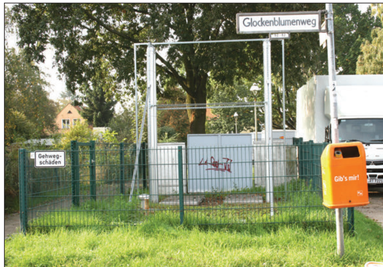
Seit dem 30. Juni ist die Brunnengalerie im Glockenblumenweg Ecke Arnikaweg, die rund 4000 Eigenheimen im Rudower Blumenviertel das Grundwasser fern hielt, wie geplant abgeschaltet. Foto: Bothe
